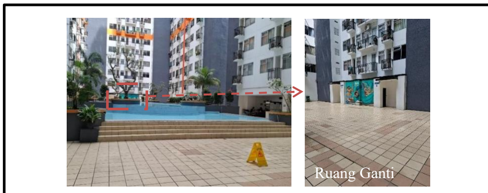
Gambar 6. Fasilitas kolam renang (kanan) dan ruang ganti (kiri) pada Apartemen The Jarrrdin Sumber : 2024
