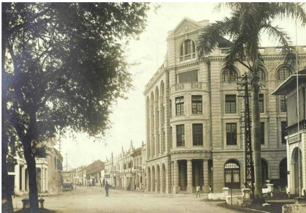
Gambar 1. Gedung London Sumatera dibangun pada tahun 1906 dan dijadikan sebagai kantor perkebunan Harrison & Crossf
